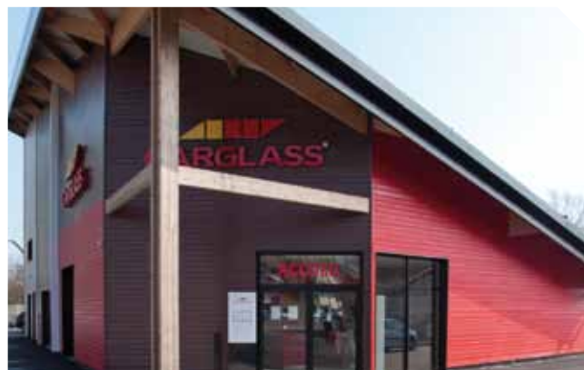
Le centre de Dax est un site éco-conçu, équipé de 1 000 m 2 de panneaux photovoltaïques et d'un système de récupération d'eau.
